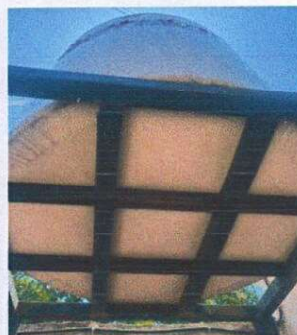
Foto 4: Refuerzo de base de metal con tubería de 4x4 galvanizada y base con platina de 1/8 en el area de deposito de agua
