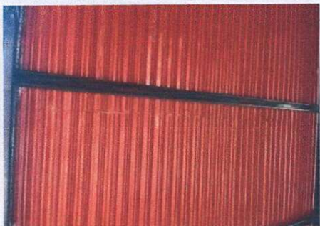
Foto 1: Sustitución de estructura galvanizada con tubería de 4x4 y porta laminas de 2x36 en area de patio
