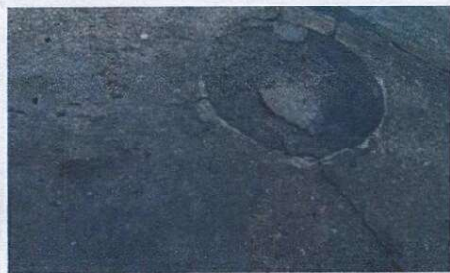
Foto 3: Sustitucion de losa de concreto en area del patio
