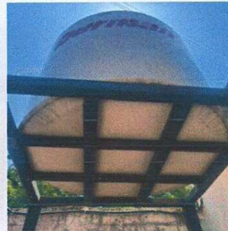
Foto 4: Refuerzo de base de metal con tubería de 4x4 galvanizada y base con platina de 1/8 en el area de deposito de agua
