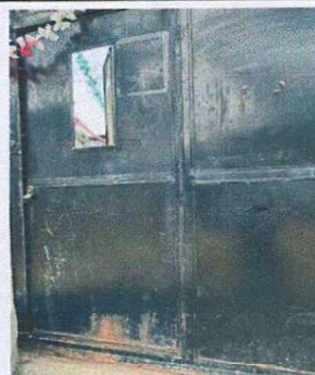
Foto 2: Sustitución de portón correrizo principal de metal con tubería de 1 1/2 chapa #16 de 2.15 de ancho x 2.60 de alto en el ingreso
