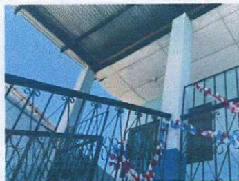
Foto 5: Sustitución de baranda de metal en area de grada
